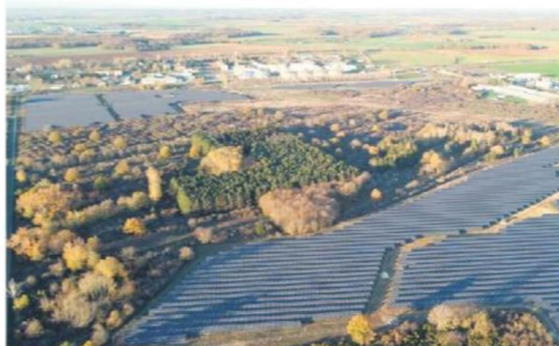
Autorisée en 2021 par la préfecture de l'Indre, la mise en service du second parc solaire de La Martinerie est prévue en 2024. (Photo BayWa r.e.)
